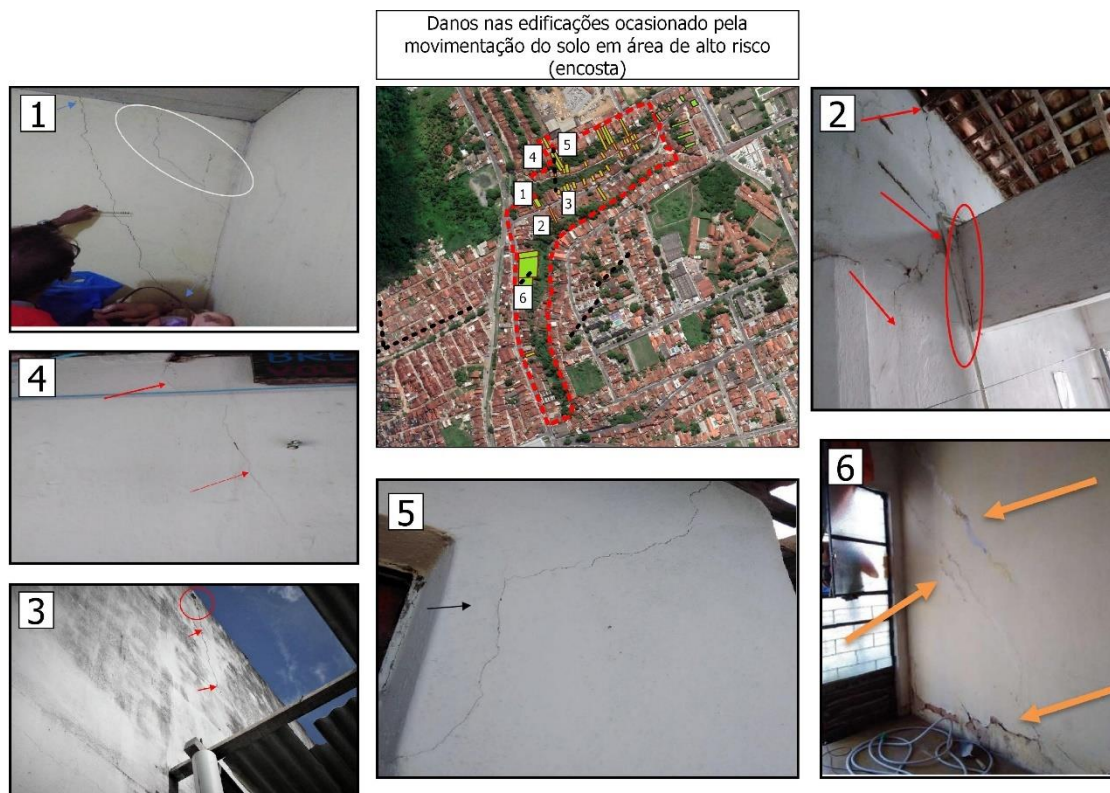
Figura 7 - Danos e feições em área de Encosta (Setor 1).
